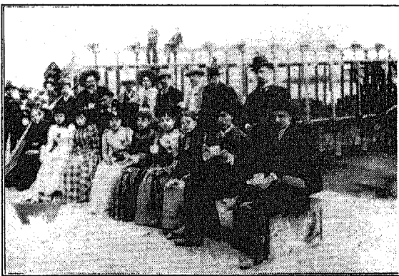
Inauguración de las Compuertas de la Presa, San Fernando, los empresarios de aquel entonces representados por el Sr. Ángel Hernández Luengas
